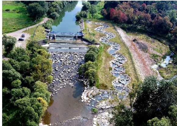
Wiśłoka River – Szczepanowa after construction
